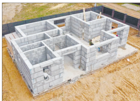
Рис. 4. Строительство дома из крупноформатных полистиролбетонных панелей Fig. 4. Construction of a house made of large-format polystyrene concrete panels
