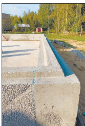
Рис. 4. Строительство дома из крупноформатных полистиролбетонных панелей Fig. 4. Construction of a house made of large-format polystyrene concrete panels
