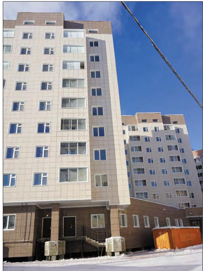
Рис. 3. Монолитно-каркасный жилой дом с применением пенобетонных блоков автоклавного твердения в Якутске
