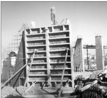
Рис. 1. Опалубка стен
