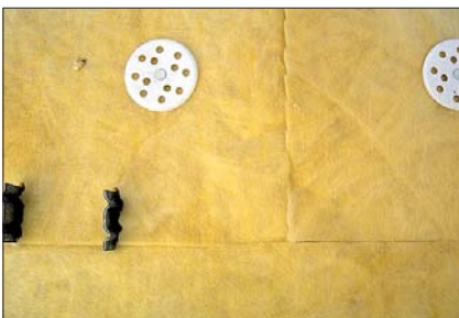
Рис. 8. Межпанельные стыки
