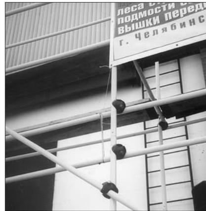
Леса, скрепленные шаровыми зажимами «Мастер» фирмы «Уралпромсервис», отличаются повышенной жесткостью конструкции
