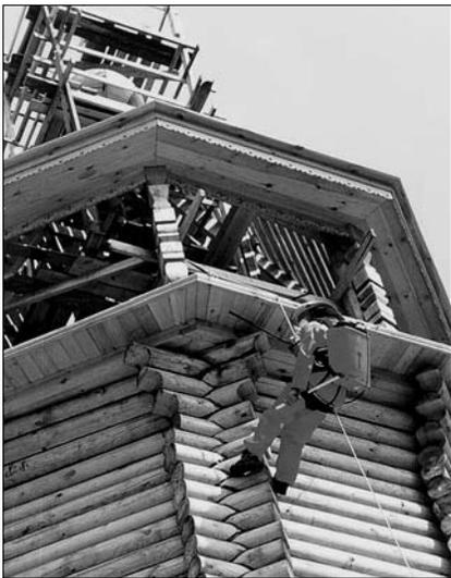
**Рис. 1.** Все чаще при новом строительстве архитекторы обращаются к традициям русского деревянного зодчества, но с использованием современных технологий. Православный храм в Жулебино (Москва) в процессе обработки составом «ПИРИЛАКС»
