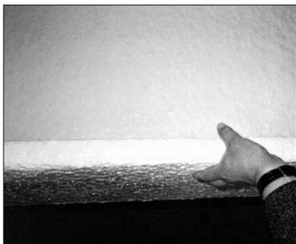
Рис. 1. Внешний вид покрытия ОПВ-ТСВ с огнезащитной эффективностью 1,5 ч
