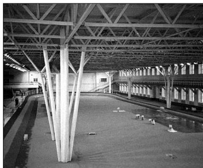
Рис. 2. Несущие металлические конструкции легкоатлетического манежа (Екатеринбург, 2001 г.)
