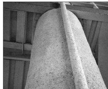
Рис. 3. Колонна с покрытием «Вермивол». Предел огнезащитной эффективности 1,5 ч
