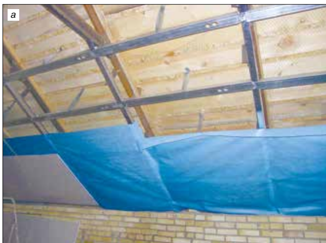
Рис. 3. Возведение мансарды коттеджа с использованием крупнопористого керамзитобетона: a – установка крепежных элементов несъемной опалубки с использованием гипсокартона; b – стадия завершения строительно-монтажных работ
