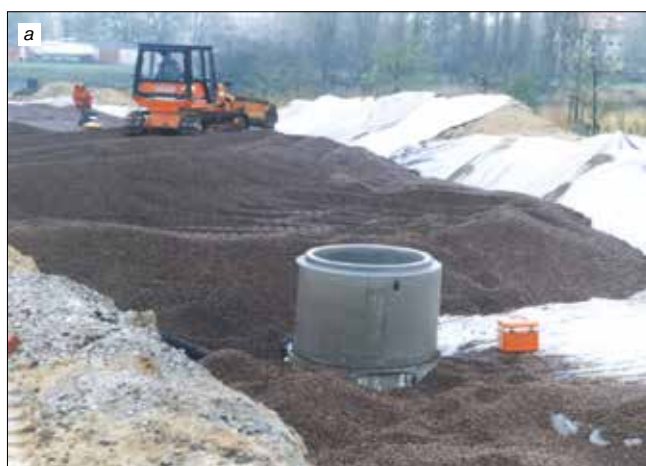
Рис. 10. Автострада в Чехии, построенная на подтопляемых территориях с использованием керамзита: а – устройство керамзитовой подушки в оболочке из геосинтетики; б – автострада в стадии эксплуатации
