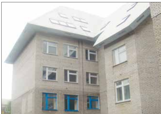
Рис. 5. Внешний вид двухэтажной мансарды (с крупнопористым керамзитобетоном) Башкирского социально-экономического техникума после 20 лет эксплуатации Fig. 5. Appearance of a two-story attic (with large-pore expanded clay concrete) of the Bashkir Social and Economic College after 20 years of operation
