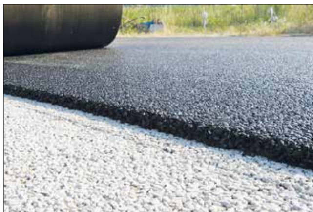
Рис. 6. Укладка сверху основания автомобильной дороги из дренажного бетона КАПСИМЭТ слоем покрытия дорожной одежды – дренажным асфальтобетоном по СТО АВТОДОР 2.15–2016 «Смеси асфальтобетонные и асфальтобетон дренажные. Технические условия»
