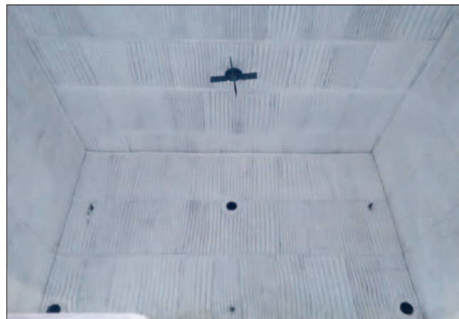
Рис. 4. Футеровка печи Fig. 4. Kiln lining
