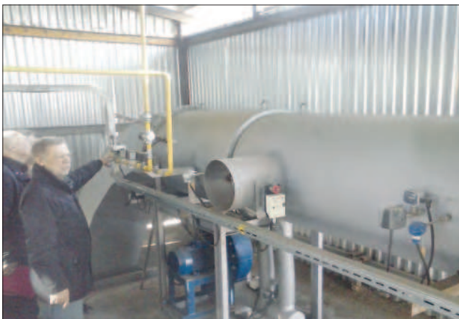
Рис. 3. Термический нейтрализатор Fig. 3. Thermal neutralizer
