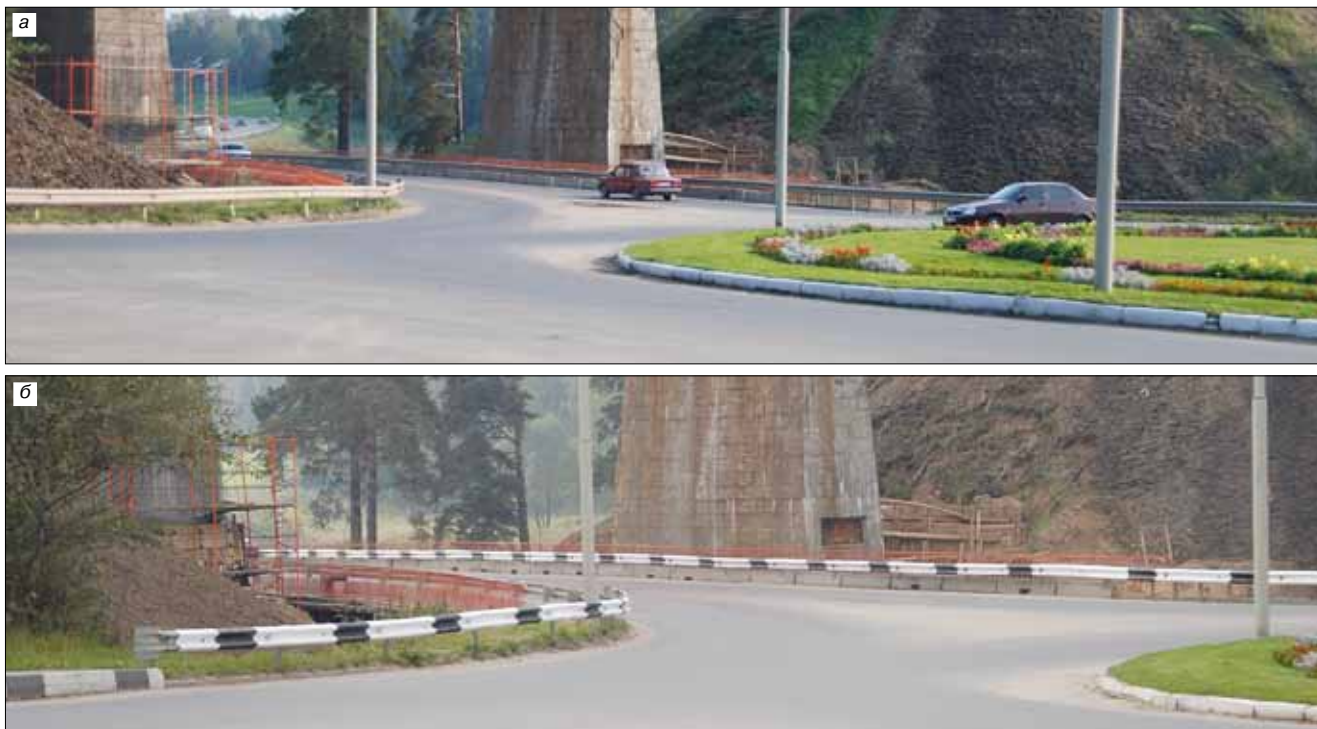
Рис. 3. Вид барьерного ограждения до (а) и после (б) применения вертикальной разметки
