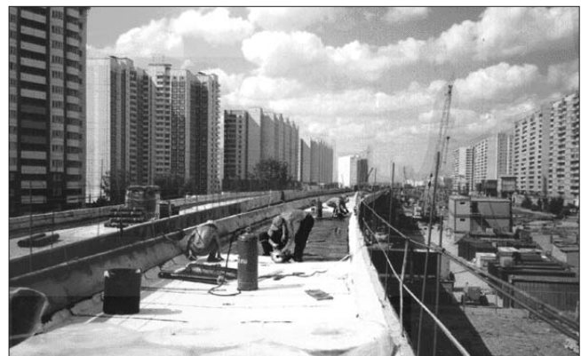
Рис. 2. Изоляция пролетных строений легкого метро полифункциональной системой Днепротекс
