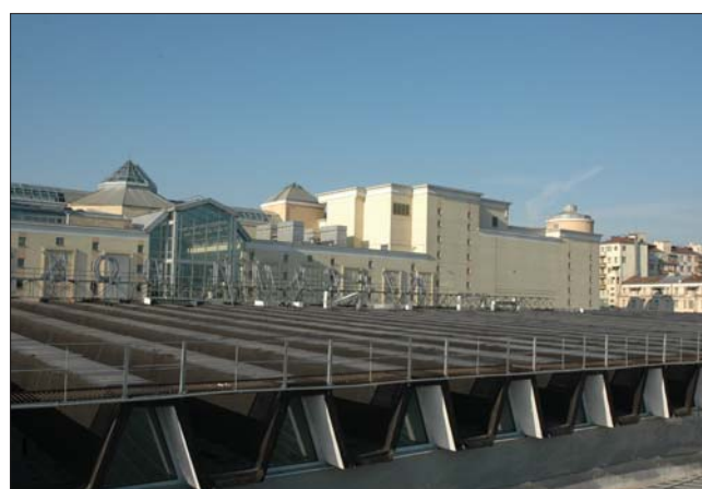
Рис. 10. Отремонтированная кровля главного здания Курского вокзала после сдачи в эксплуатацию в 2008 г.
