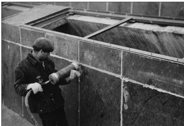
Рис. 3. Герметизация швов тиоколовым герметиком УТ-32. 1970 г.
