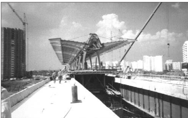
Рис. 2. Изоляция пролетных строений легкого метро полифункциональной системой Днепротекс
