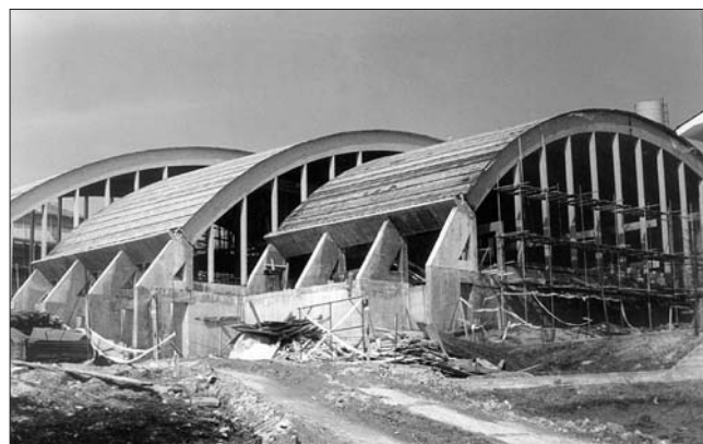
Рис. 6. Конструкции спортивного комплекса «Буря». Пролеты 24, 29, 34 м
