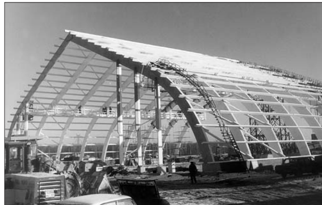
Рис. 5. Арочные конструкции склада противогололедных реагентов на ул. Суздальской в Москве. Пролет 60 м, высота 21 м
