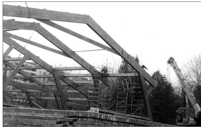
Рис. 4. Рамные конструкции торгового дома. Пролет 25,5 м
