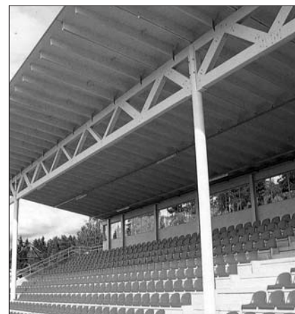
Рис. 3. Использование балок LVL в строительстве
