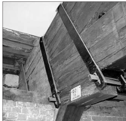
Рис. 2. Опорный узел
