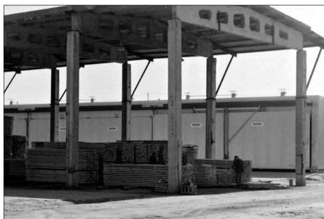
Участок атмосферной сушки пиломатериалов и сушильный комплекс Muhlbock
