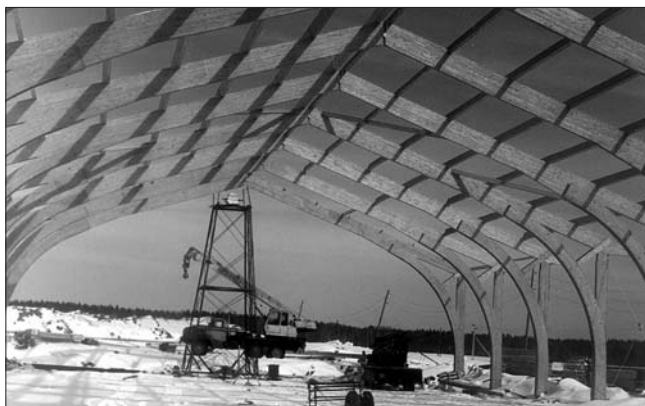
Рис. 1. Рамные конструкции главного манежа конно-спортивного комплекса «Новый век». Пролет 26 м, высота 12 м
