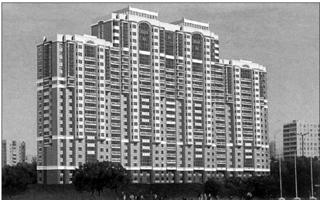
Рис. 3. Жилой 23-этажный панельный дом серии ПЗМ-7. Производитель и заказчик ДСК-3
