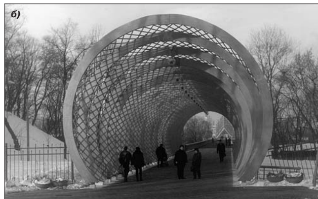
Рис. 6. Конструкции спортивного комплекса «Буря». Пролеты 24, 29, 34 м
