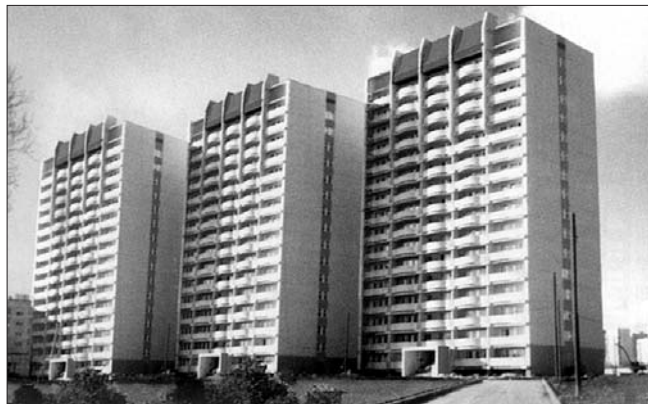
Рис. 4. Панельно-блочный 16-этажный жилой дом. Заказчик и инвестор СУ-155
