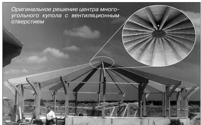
Рис. 2. Рамные конструкции манежа-погонялки. Пролет 18 м, высота стоек у карниза 4 м, подъем ригеля в центре 8 м
