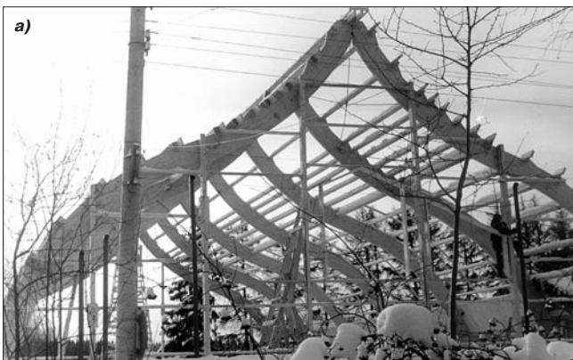
Рис. 7. а) – арочные конструкции теннисного корта в п. Снегири Московской области. Пролет 18 м; б) – пергола схода Андреевского моста в Нескучном саду (Москва)
