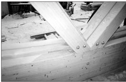
Рис. 4. Узел решетки линзообразной фермы
