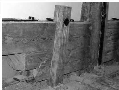
Рис. 5. Разрыв нижнего пояса фермы Ф5
