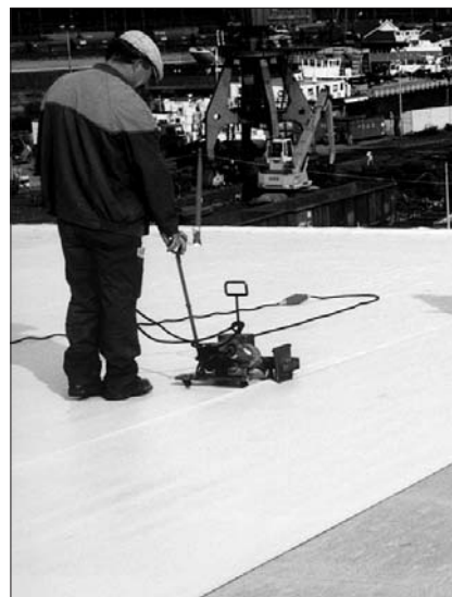
Рис. 4. Сварка кровельных материалов горячим воздухом позволяет создать практически герметичное покрытие
