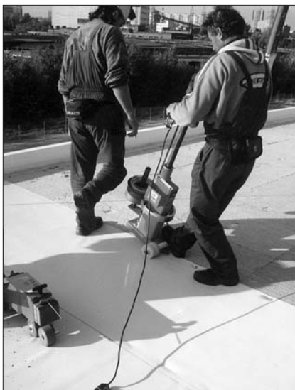
Рис. 3. Механический способ крепления кровельных мембран. Материал «Sikaplan 15 VGWT». Торговый комплекс «Метро Кэш энд Керри» (Москва)
