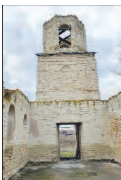
Рис. 3. Разрушенная церковь иконы Божией Матери «Одигитрия» в Ростовской области, сложенная блоками из карбонатных опоковидных пород, находящаяся без крыши более 60 лет
