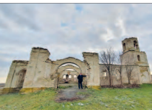
Рис. 3. Разрушенная церковь иконы Божией Матери «Одигитрия» в Ростовской области, сложенная блоками из карбонатных опоковидных пород, находящаяся без крыши более 60 лет
