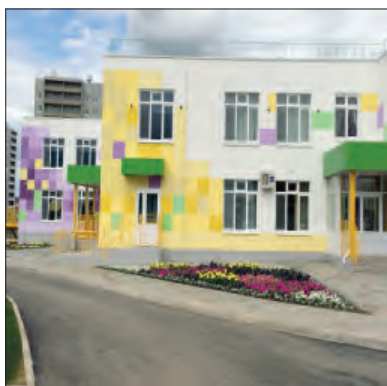
Рис. 2. Детский сад из сборного железобетона Fig. 2. Kindergarten made of precast reinforced concrete
