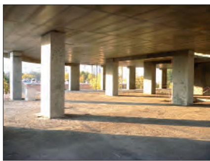
Рис. 1. Несущие конструкции стен, колонн и постнатяженных перекрытий пролетом 8 м здания «Gazoil Plaza» (Москва) из конструктивного легкого бетона фактических классов Вф45–Вф50
