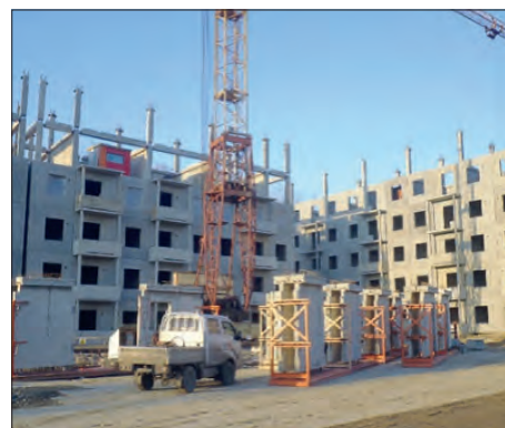
Рис. 3. Строительство жилых домов Fig. 3. Construction of residential buildings
