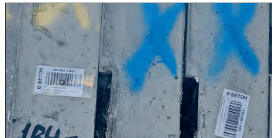
Рис. 3. Штрихкодирование в тело бетона Fig. 3. Barcoding into the concrete body
