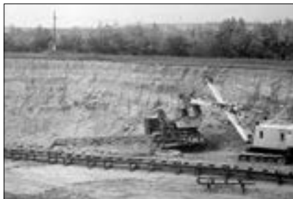
Рис. 2. Разработка вскрышных пород на Бугураевском карьере (фото Буткевича Г.Р.)
