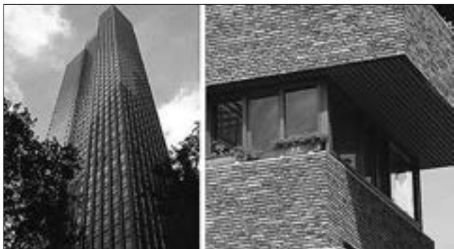
Рис. 3. Примеры зданий с навесными кирпичными фасадами в Западной Европе.
