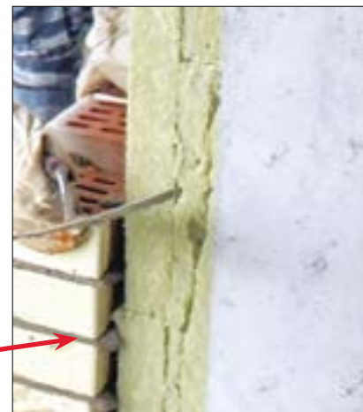
Рис. 3. Перекрытие вентиляционного зазора кладочным раствором
