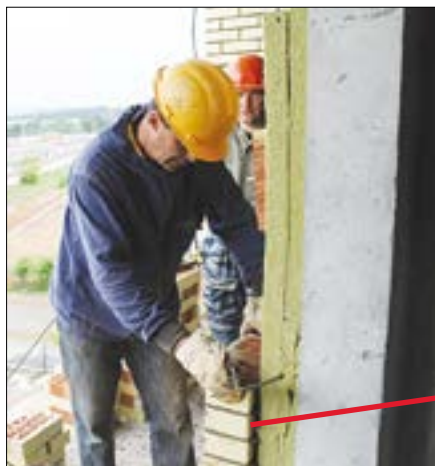
Рис. 3. Перекрытие вентиляционного зазора кладочным раствором
