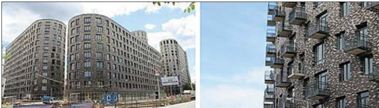
Рис. 4. Примеры зданий с навесными фасадными системами в России (г. Москва)
