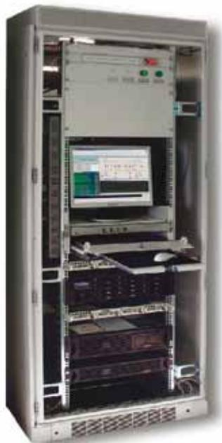
Шкаф управления АСУТП «КирЗавод». Включает в себя сервер, источники бесперебойного питания, платы ввода/вывода данных, платы коммутации и управления. Шкаф управления содержит локальную систему вентиляции
