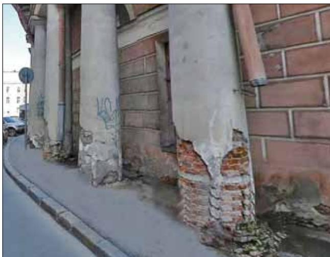
Рис. 3. Разрушенные колонны (Конюшенная пл.)
