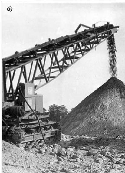
**Рис. 5.** Бункер-питатель, загружаемый драглайном (а), и отвалообразователь (б) на вскрышных работах Люберецкого карьероуправления кварцевых песков (50-е годы)
