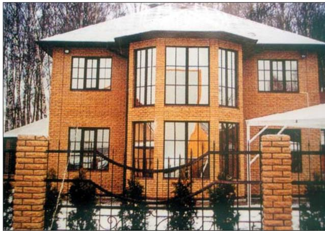
Рис. 3. Дом из лицевого кирпича, построенный в Подмоскowie. Забор и стены – из кирпича с объемным сколом. Кирпич с желтым пигментом поставлен из Калужской обл. (п. Товарково)
