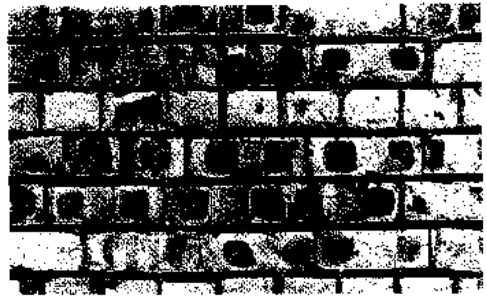
Рис. 3. Фрагмент кирпичной кладки с темными пятнами на ложковых гранях кирпича
