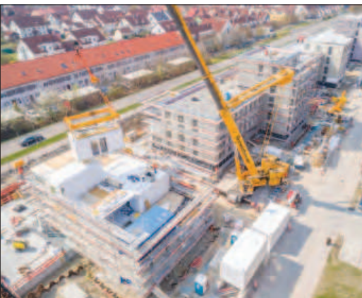
Модульное производство позволяет сократить сроки строительства благодаря высокой степени заводской готовности Modular production makes it possible to reduce the construction time due to the high degree of factory readiness
