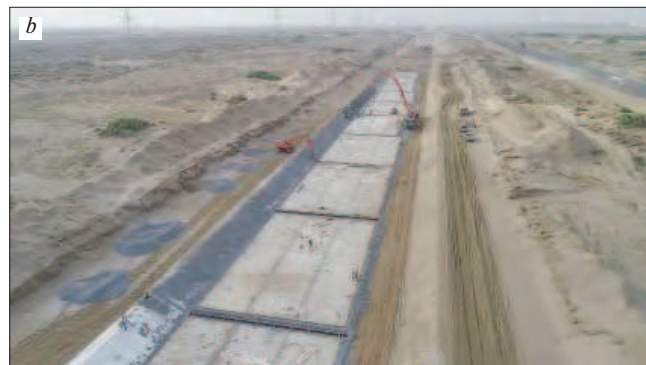
Рис. 5. Устройство дренажного слоя: а – плита дна; б – откосы. Укладка дренажного слоя на откосы канала производилась после завершения устройства подготовительного бетонного слоя
