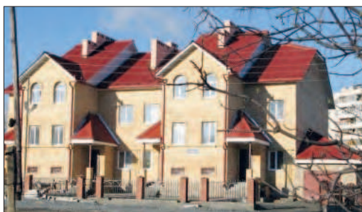
Малозэтажный дом с асбестоцементными листами и трубами в опалубке и с заливкой внутри легким пенобетоном Low-rise house with asbestos cement sheets and pipes in the formwork and with filling inside with light foam concrete
