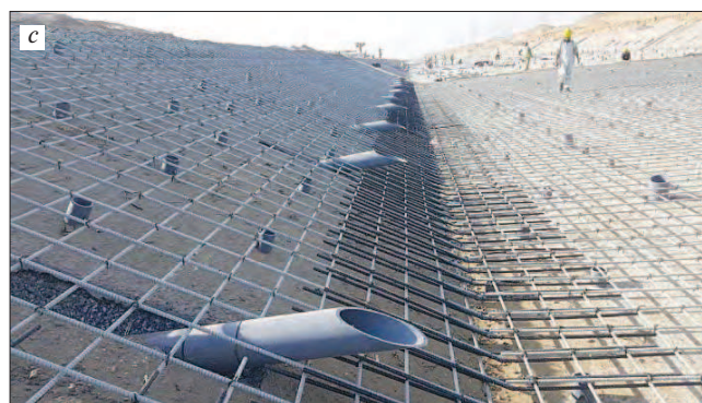
Рис. 7. Откосы канала, привязанные к плите дна с помощью специально изготовленных соединительных стержней: a – рабочий несет в руке пучок соединительных стержней; b – верхняя часть канала до укладки бетона, видны сетка, дренажные отверстия, опалубка; c – детализированный вид стыков внахлест на участке привязки откосов ко дну канала Fig. 7. The sloped sides of the JEC-FMC were tied to the base slab using bespoke splice bars: a – a worker carries a bundle of splice bars; b – prior to concrete placement, an overview of an upstream section of the JEC-FMC, showing grids, weep holes, and channel edge formwork; c – detail of lap splice at base-slope intersection
