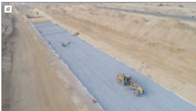
Рис. 5. Устройство дренажного слоя: а – плита дна; б – откосы. Укладка дренажного слоя на откосы канала производилась после завершения устройства подготовительного бетонного слоя
