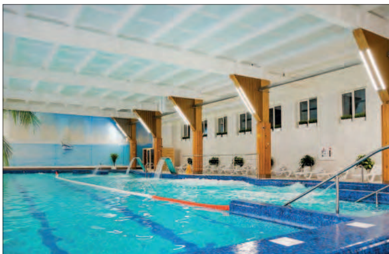
Рис. 1. Окрашенные металлоконструкции водно-развлекательного комплекса Fig. 1. Painted metal structures of the water entertainment complex
