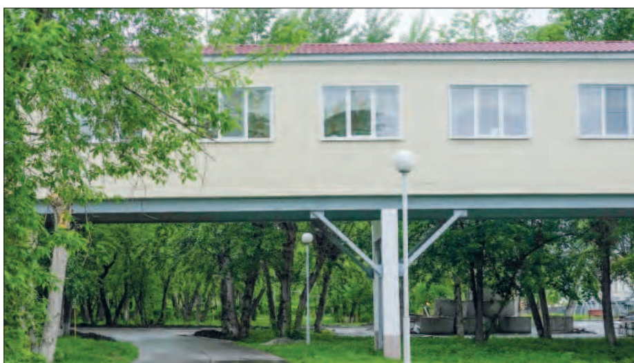
Рис. 2. Окрашенные металлоконструкции теплых переходов и специальных технологических устройств Fig. 2. Painted metal structures of warm transitions and special technological devices
