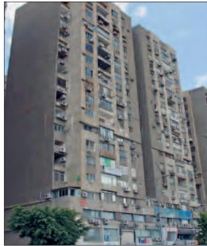
Рис. 4. Здания в Каире, покрытые загрязнениями от выхлопных газов и дисперсной пыли от воздействия песчаных бурь
