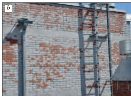
Рис. 1. Отслоение акриловой краски на парапетах кирпичных зданий в г. Ижевске: a – комплекс «Максима»; b – комплекс «Горизонты» Fig. 1. Peeling of acrylic paint on the parapets of brick buildings in the city of Izhevsk: a – the Maxima complex; b – the Horizons complex
