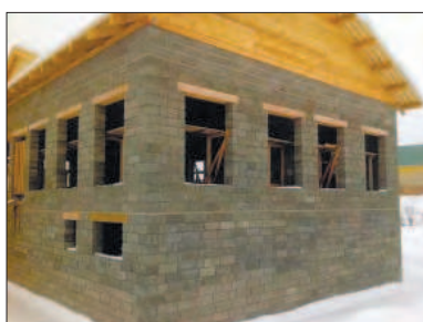
Рис. 3. Внешний вид коробки здания, построенной с использованием блоков (рис. 2, а) с льняным наполнителем ( https://build2last.ru/megacat/portfolio_detailed_img/2665/1556713227/0/dom-iz-arbolita/1.jpg )
