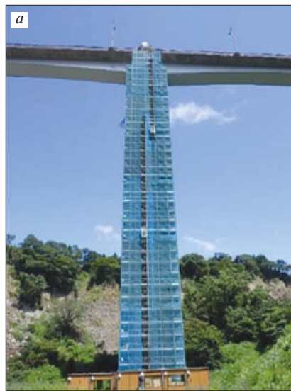
Рис. 11. Строительные леса и сооружение для подъема техники на высоту моста (а); завершённая работа по восстановлению опоры моста (б) Fig. 11. Scaffolding and lifting facility to the height of the bridge (a); completed work on the restoration of the bridge support (b)
