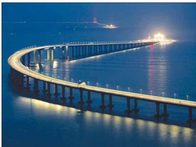
Рис. 2. Общий вид двухъярусного (с подводной частью) моста между Гонконгом и материковой частью Китая (Чжухай и Макао)
