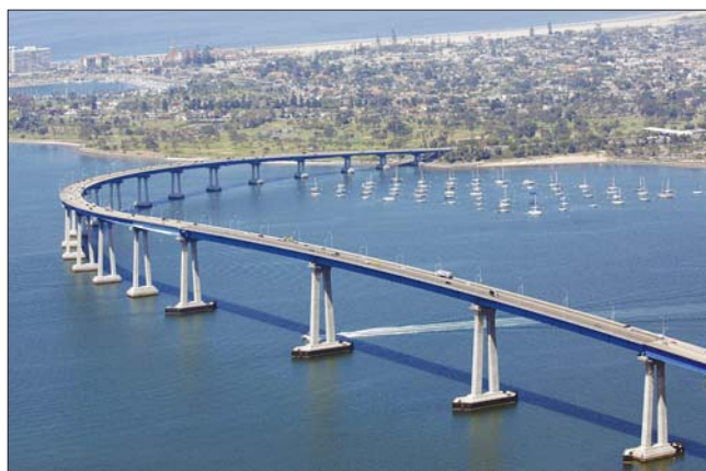
Рис. 5. Мост Коронадо (Калифорния, США) протяженностью 3407 м и высотой 61 м. Мост построен в 1969 г. из конструкционного легкого бетона класса по прочности LC40 и марки по средней плотности D1800 на пористых заполнителях из вспученных глинистых сланцев
