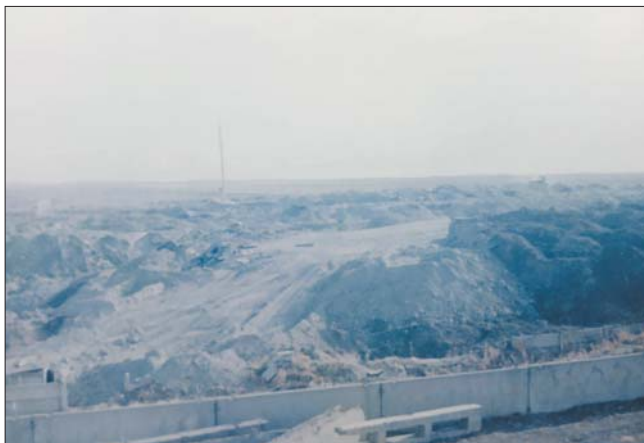
Рис. 1. Шламохранилище Ахангаранского шиферного завода Fig. 1. Sludge storage of Akhangaran Shifter Plant
