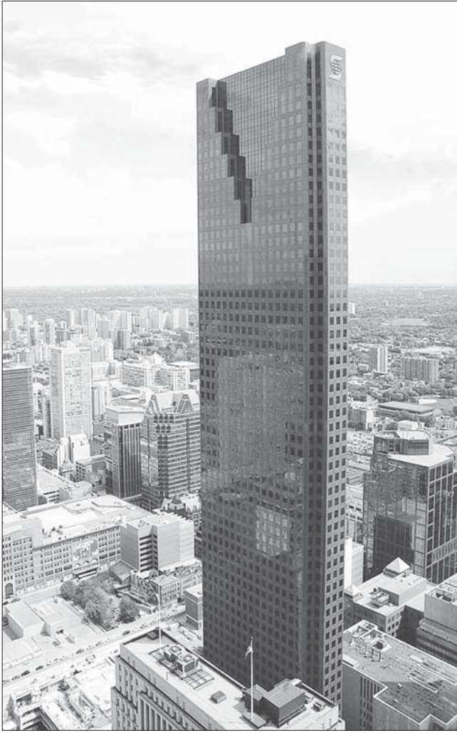
Рис. 7. Здание «Scotia Plaza Tower» (69 этажей, 276 м) в финансовом районе г. Торонто (Канада). Перекрытия высокой огнестойкости (класс K_0 при \tau_{огн}=2 ч) выполнены из монолитного легкого бетона класса по прочности LC30–LC40 марки по плотности D1800–D1900 на основе пористого шлакового гравия (pelletized slag) с использованием шлаковых цементах (типа «blended cements»-ASTM, 1990 г.)
