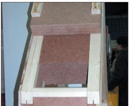
Рис. 4. Изоляционные плиты СОФТБОРД можно использовать для тепло- и звукоизоляции стен, крыш и пола.
