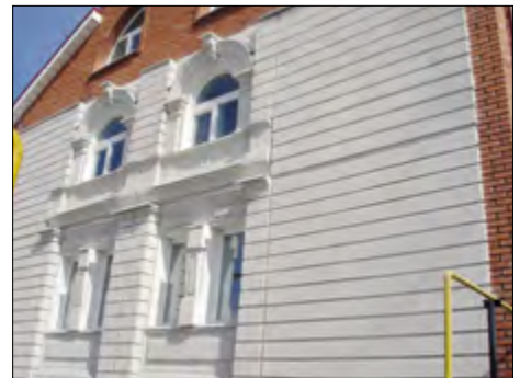
Рис. 10. Фрагмент фасада здания с СМК и трехслойной «НС» высокой заводской готовности с отделкой фибробетоном. 2015 г., г. Чебоксары. ГК «Рекон-СМК»
