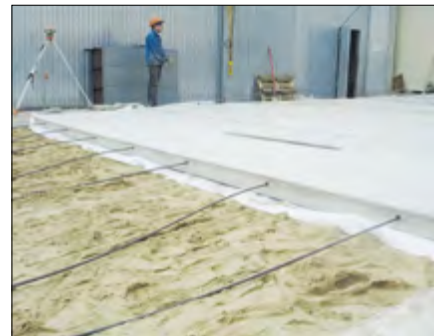
Рис. 13. Строительство участка дороги с применением преднапряженных пазогребневых дорожных плит. Сентябрь 2014 г., г. Чебоксары, ЗАО «РЕКОН»
