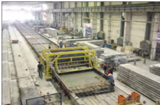
Рис. 12. Формование преднапряженных пазогребневых плит с постнапряжением на универсальном стэнде с применением универсального вибробетонукладчика. Октябрь 2014 г., г. Чебоксары. ОАО «Монолитстрой»
