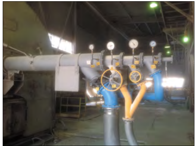
Рис. 3. Многоканальная газозвдушная горелка, установленная на печи 3,6×75 м
