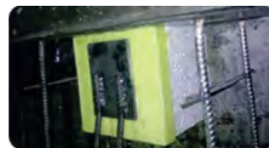
Фиксация пенополистирола к форме и металлической закладной к пенополистиролу.
