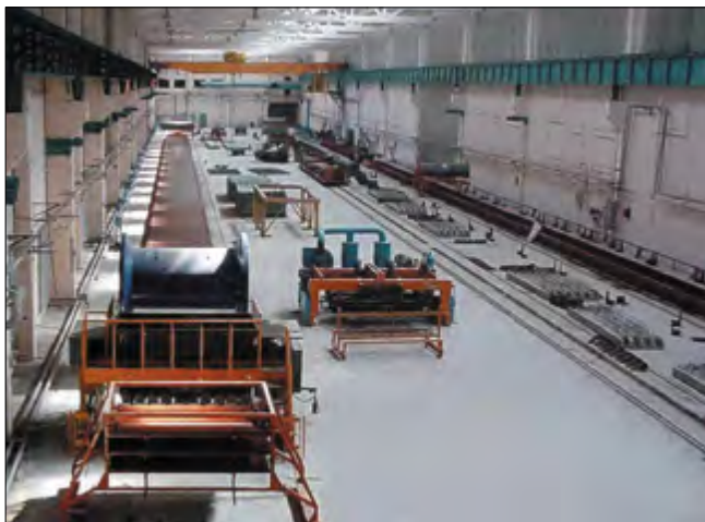
Рис. 1. Технологическая линия по производству элементов сборно-монолитного каркаса: колонн, преднапряженных ригелей и плит несъемной опалубки
