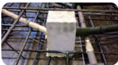
Фиксация элементов электро-разводки.
