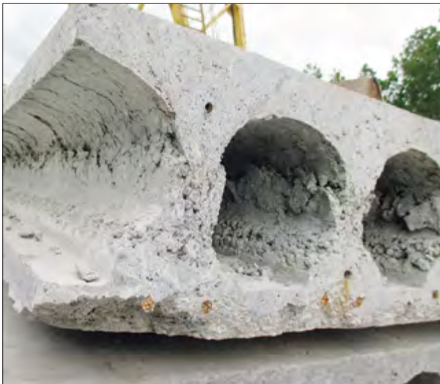
Рис. 1. Типовой производственный дефект стенового формования: обрушение массива продольных ребер
