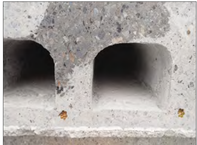
Рис. 3. Торец плиты, изготовленной из оптимизированных составов бетонной смеси
