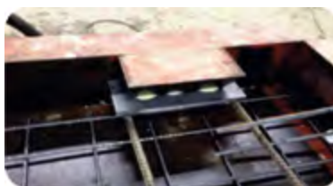
Фиксация металлической закладной после нанесения CASTTEC-клея.
