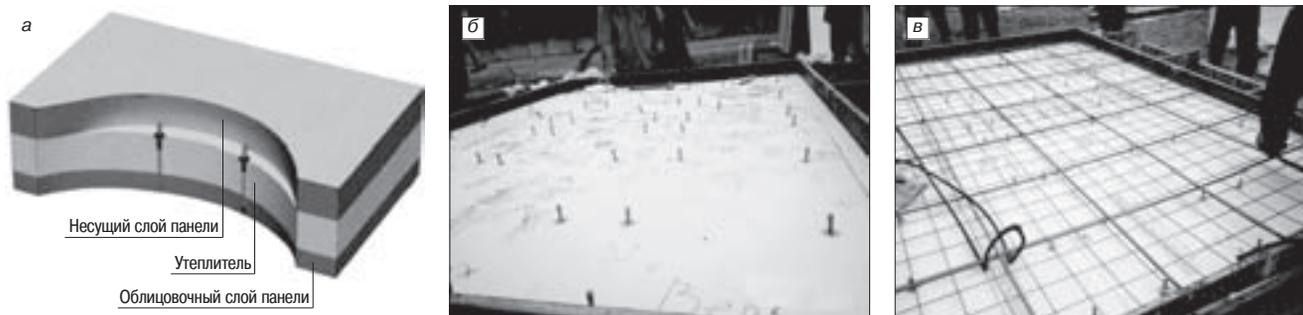
Рис. 2. Трехслойная железобетонная панель с применением гибких связей из стеклопластиковой арматуры диаметром 7,5 мм: а – макет; б – установка дюбелей; в – монтаж арматуры
