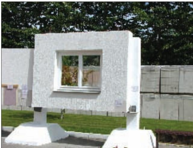
Рис. 1. Стеновая панель на комнату полной заводской готовности
