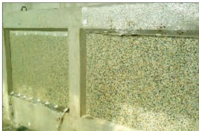
Рис. 4. Панель ограждения лоджии ОЛ-4 с декоративным покрытием из краше ной мраморной крошки
