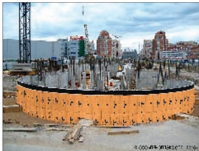
Рис. 2. Плиты ПЕНОПЛЭКС® при сооружении подземных частей зданий
