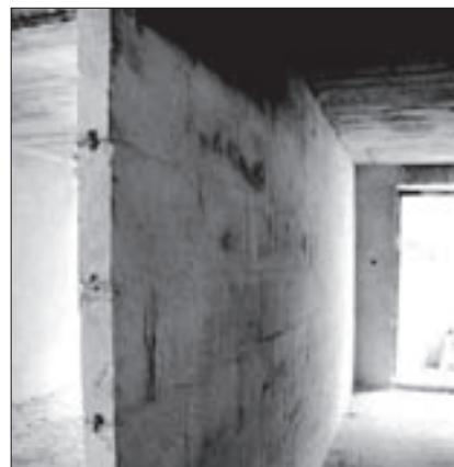
Рис. 2. Межкомнатная перегородка из блоков пазопанельной формы после выполнения кладочных работ
