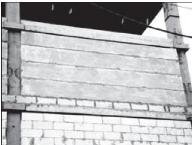
Рис. 6. Опираание панелей на полуку ригеля каркаса дома
