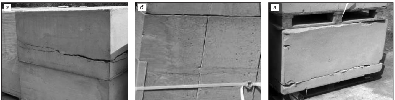
Рис. 2. Деформации пенобетонных блоков: а – через 12 ч на турецком цементе; б – через 7 дней на оскольском цементе; в – через 10 ч на турецком цементе
