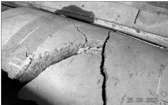
Рис. 4. Характер трещин после испытания
