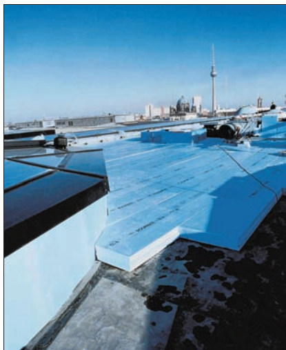
Рис. 1. В инверсионной кровле слой теплоизоляции располагается поверх гидроизоляции
