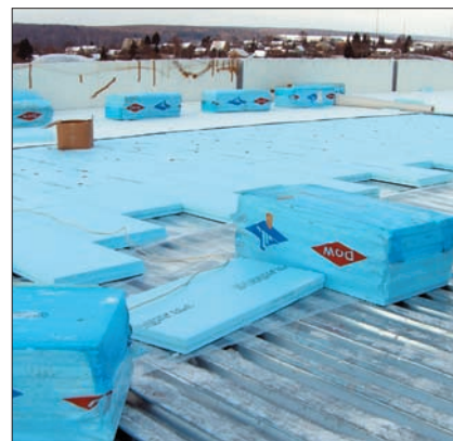
Рис. 2. Теплоизоляция кровель традиционной конструкции
