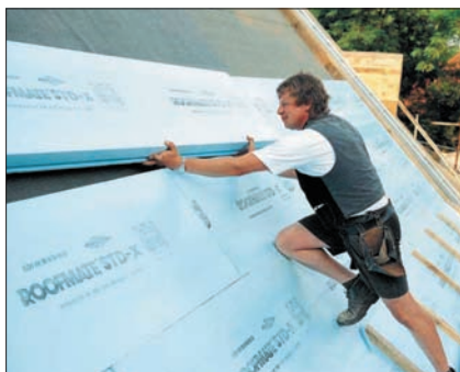
Рис. 3. Теплоизоляция скатных кровель
