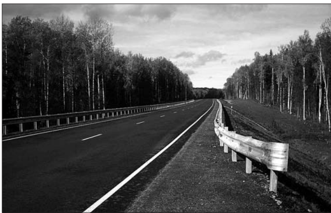
Рис. 2. Щебеночно-мастичное асфальтобетонное покрытие с разметкой и ограждающими конструкциями
