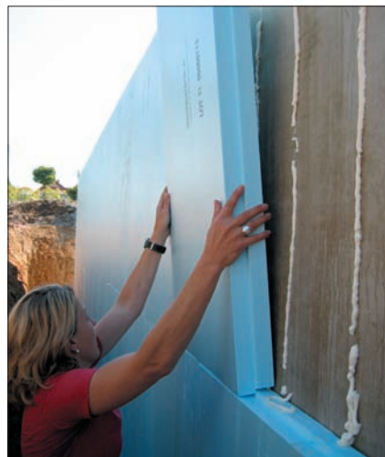
Рис. 5. Теплоизоляция подземной части здания
