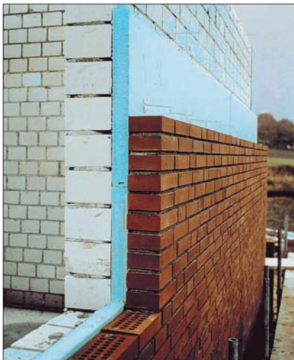
Рис. 4. Теплоизоляция стен
