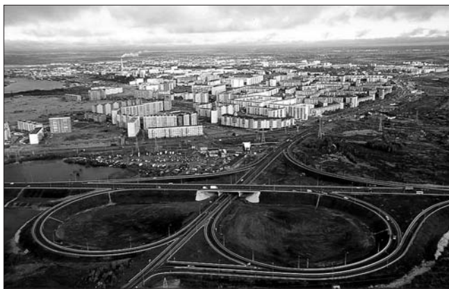
Рис. 1. Развязка дороги Нефтеюганск – Сургут с полимерасфальтобетонным покрытием
