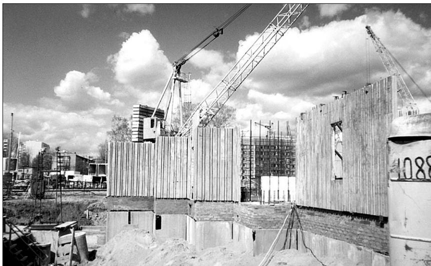
Рис. 2. Общий вид монтажа сборных скорлуп оставляемой опалубки.
