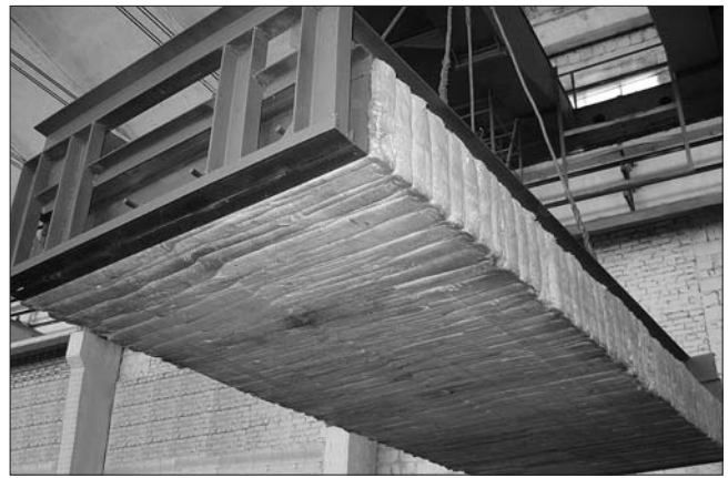
Рис. 2. Панель перекрытия туннельной печи из волокнистых огнеупоров
