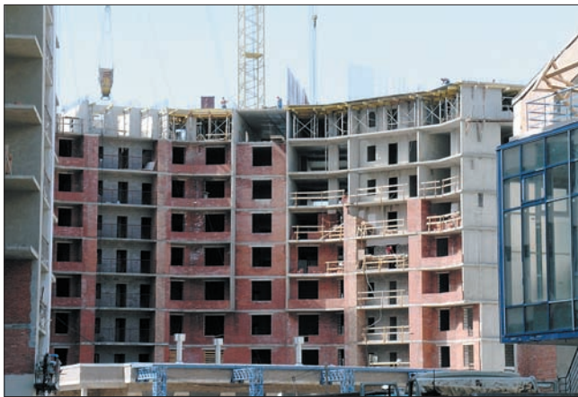
Использование кирпича в каркасно-монолитном строительстве
