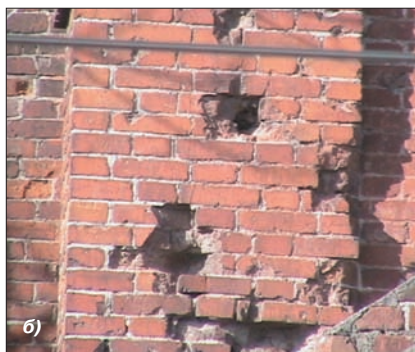
Рис. 5. Дефектные каменные и кирпичные конструкции, которые продолжают эксплуатироваться: а – трещина на стене современного жилого здания; б – выбоины в кладке промышленного здания; в – разрушенная поверхность кирпичной кладки из-за низкой морозостойкости раствора швов
