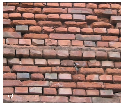
Рис. 5. Дефектные каменные и кирпичные конструкции, которые продолжают эксплуатироваться: а – трещина на стене современного жилого здания; б – выбоины в кладке промышленного здания; в – разрушенная поверхность кирпичной кладки из-за низкой морозостойкости раствора швов
