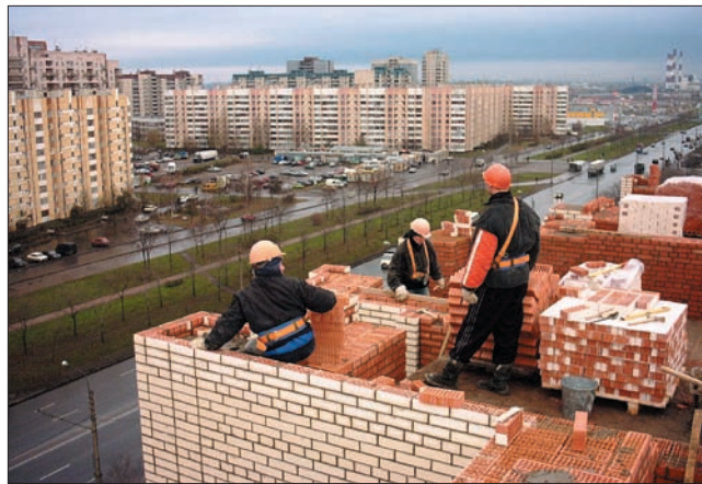
Современный каменщик – партнер архитектора
