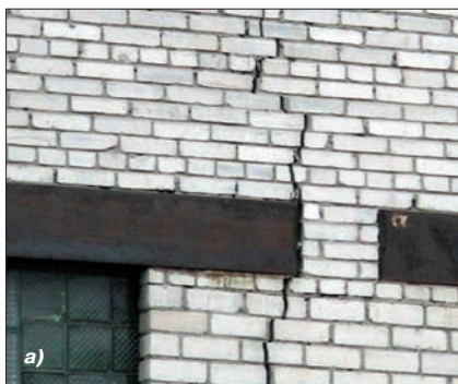
Рис. 5. Дефектные каменные и кирпичные конструкции, которые продолжают эксплуатироваться: а – трещина на стене современного жилого здания; б – выбоины в кладке промышленного здания; в – разрушенная поверхность кирпичной кладки из-за низкой морозостойкости раствора швов
