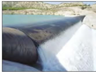
Рис. 2. Тканевая плотина
