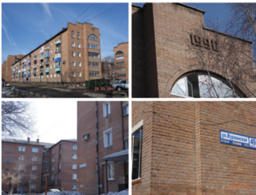
Рис. 5. Жилые дома из керамического кирпича на основе 100% отходов углеобогащения ЦОФ «Абашевская» в Орджоникидзевском районе Новокузнецка (2017 г.)
