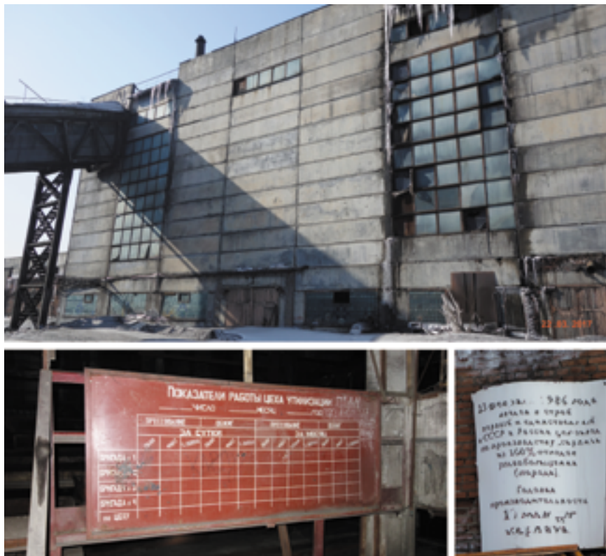
Рис. 1. Завод по производству керамического кирпича полусухого прессования из 100% отходов углеобогащения ЦОФ «Абашевская» в Новокузнецке (2017 г.)
