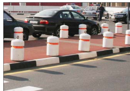
Рис. 6. Пример совместного устройства покрытия Imprint и Suregrip 924 в аэропорту
