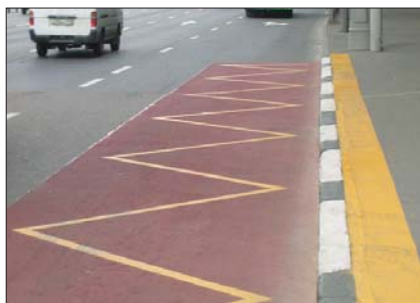
Рис. 3. Устройство цветных противоскользящих покрытий на автобусных остановках в Москве
