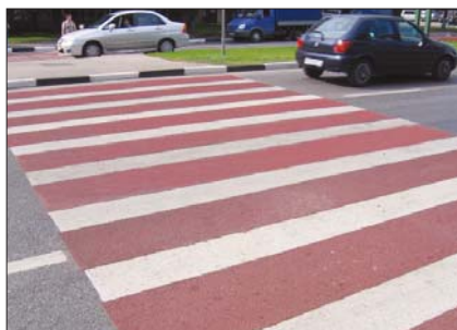
Рис. 3. Устройство цветных противоскользящих покрытий на автобусных остановках в Москве
