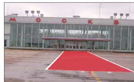
Рис. 4. Пример применения материала Suregrip 924 на дорожном покрытии в аэропорту Шереметьево
