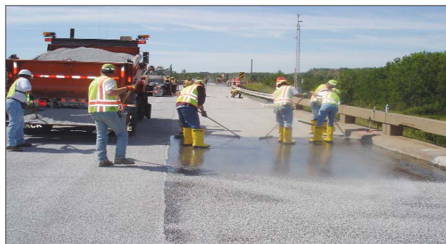
Рис. 8. Распределение эпоксидного состава и щебня
