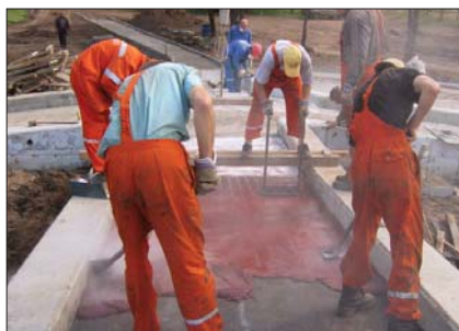
Рис. 5. Технология производства работ и окончательный вид устройства цветных противоскользящих покрытий на мостовых сооружениях из материала Imprint
