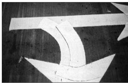
Рис. 1. Регулярная шероховатая поверхностьная обработка методом фрезерования на асфальтобетонном покрытии (Вашингтон)
