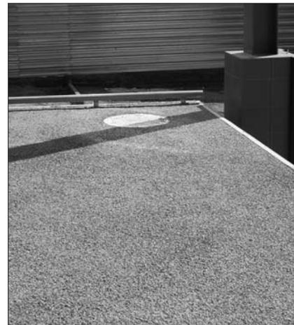
Рис. 2. Вид устроенного антигололедного дорожного покрытия с шероховатой поверхностью, сопряжение с люком
