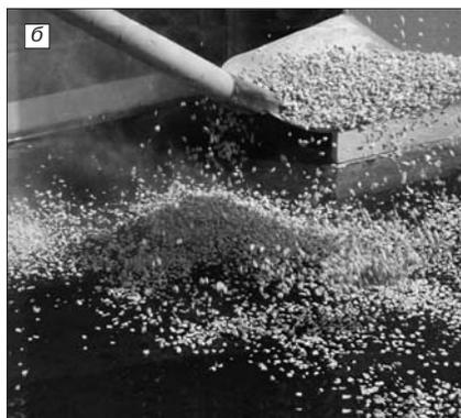
Рис. 1. Распределение эпоксидного состава (а) и щебня (б) на дорожном покрытии
