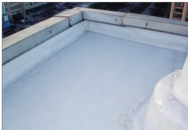
Рис. 2. Жилой дом на пр. Непокоренных в Санкт-Петербурге. Реконструкция кровли с помощью ПЛАСТФОИЛ® F
