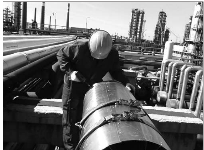
Рис. 2. Монтаж несъемной опалубки
