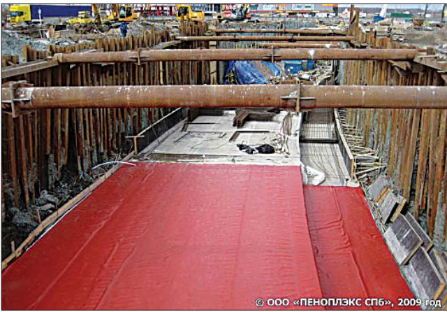
Рис. 3. Туннель, гидроизоляция которого выполнена с применением ПЛАСТФОИЛ® U (Пулковское шоссе в Санкт-Петербурге)
