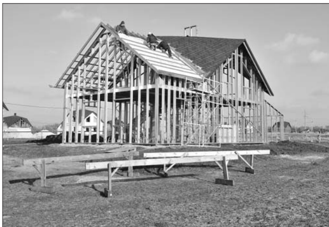
Технология несъемной опалубки на основе металлического каркаса
