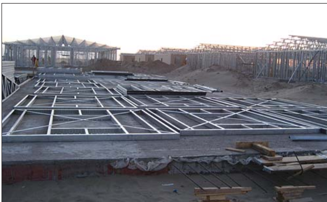
Начало строительства поселка месторождения Хаузак
