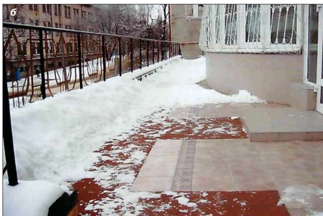
Рис. 3. Цветное покрытие из горячего пластбетона, уложенного на площадке из керамической плитки: а – летом; б – зимой
