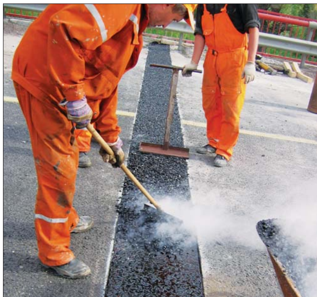
Рис. 5. Распределение вяжущего и каменного материала
