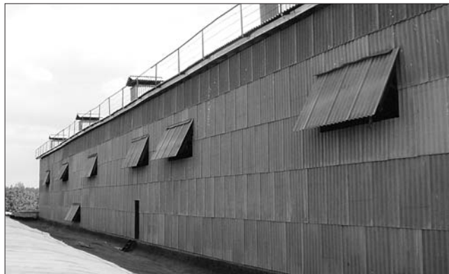
Рис. 3. Утепленные стены производственного здания на Сухоложском шиферном заводе, 2008 г.
