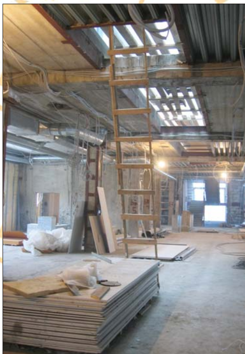
2004 год. Начало строительства офиса
