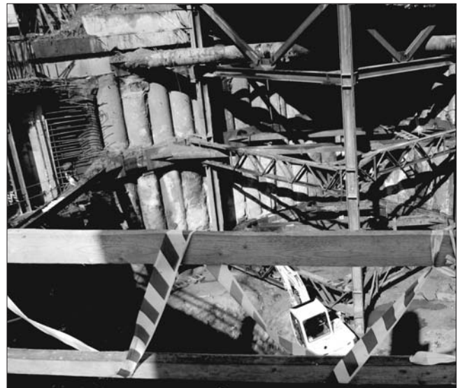
Рис. 3. Земляные работы под защитой перекрытия при строительстве подземной части высотного здания методом Up&Down по адресу Олимпийский проезд, вл. 1
