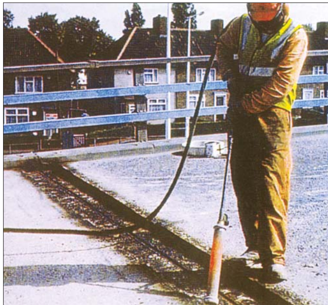
Рис. 3. Разогрев штрабы инфракрасной горелкой
