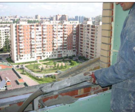
Утепление стены в многоэтажном здании
