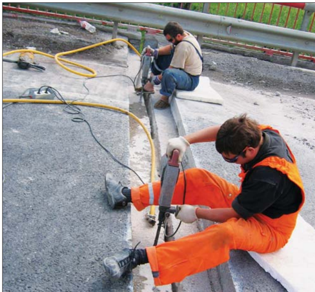
Рис. 2. Подготовка поверхности штрабы
