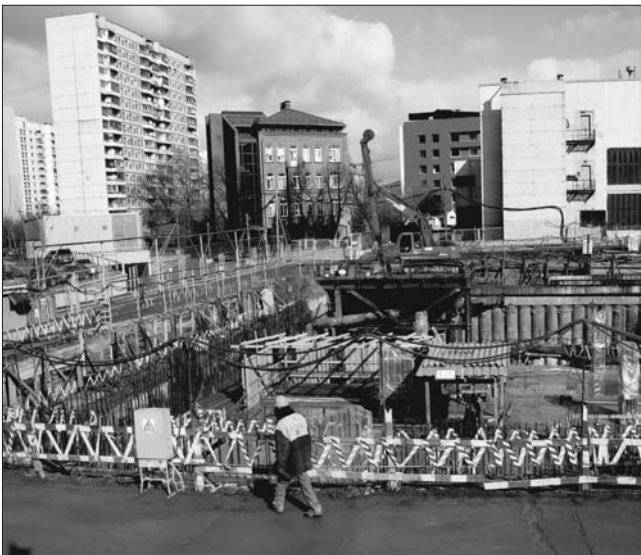
Рис. 2. Общий вид строительства подземной части высотного здания методом Up&Down по адресу Олимпийский проезд, вл. 1
