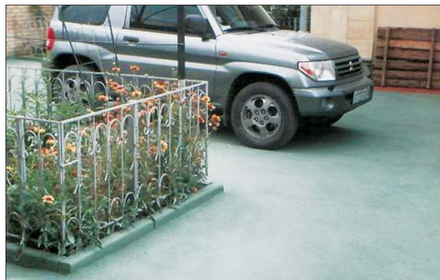
Рис. 2. Цветное покрытие двора частного дома из пластбетона на эмульгированном вяжущем
