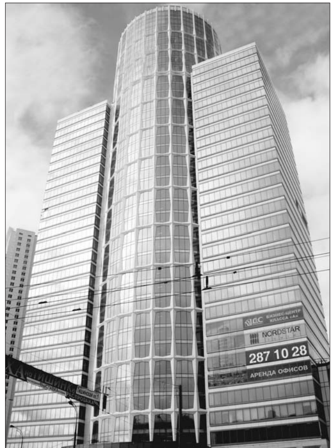
Рис. 1. Светопрозрачные фасадные конструкции на высотном здании по адресу Хорошевское шоссе, блок В (Москва)
