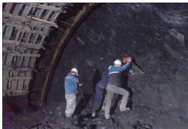
Рис. 2. Пример проведения ЭМИ СШП измерений вперед забоя
