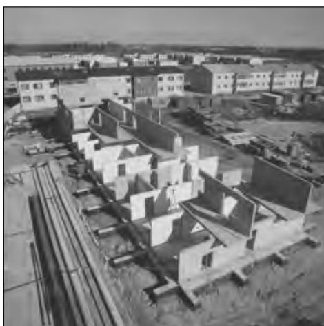
Рис. 7. Момент монтажа конструкций здания из пространственных элементов
