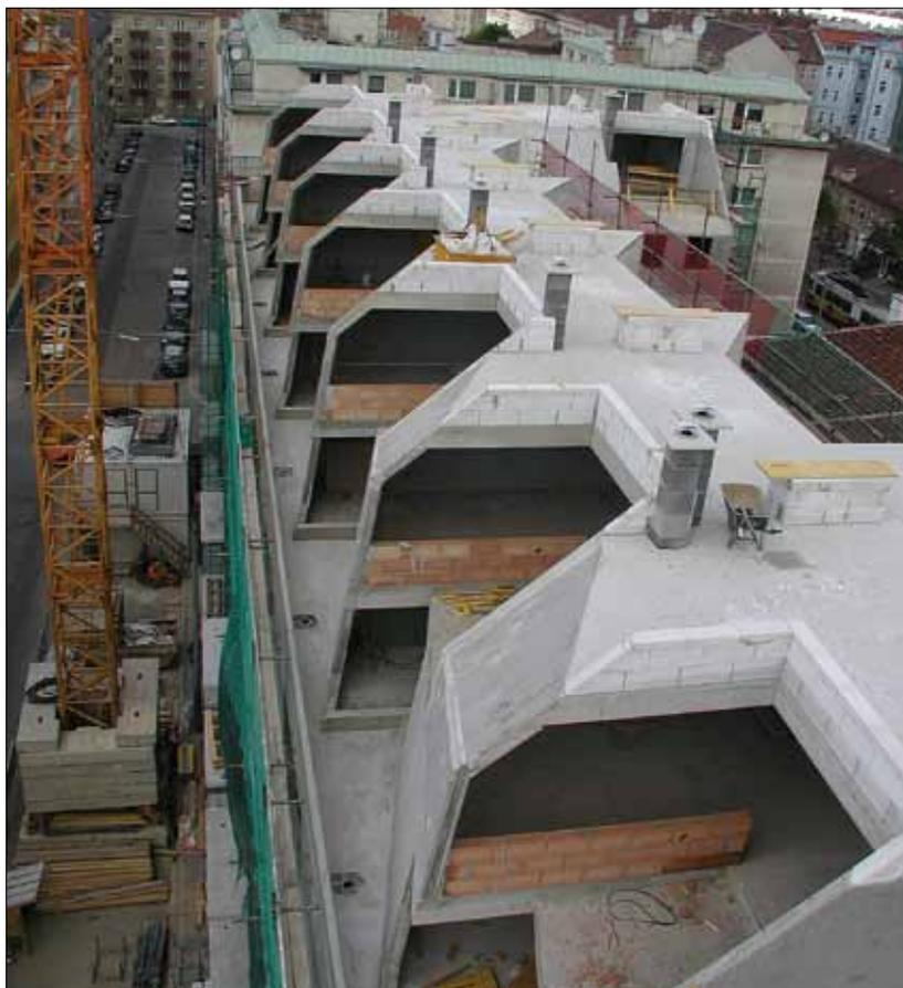
*Рис. 1. Компания Х. Катценбергер «Заводы бетонных и сборных конструкций GmbH», член группы Syspro, выполнила проект, используя сборно-монолитные перекрытия, двойные стеновые элементы и проектирование в Allplan Precast. Первоначально проект был рассчитан на исполнение в монолитном бетоне.*
