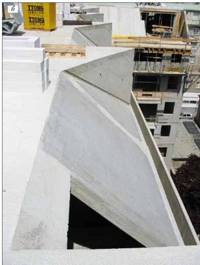
Рис. 3. Монтаж сборно-монолитных перекрытий (а, б) и двойных стен (в) в области массивной крыши проведен с высокой степенью точности
