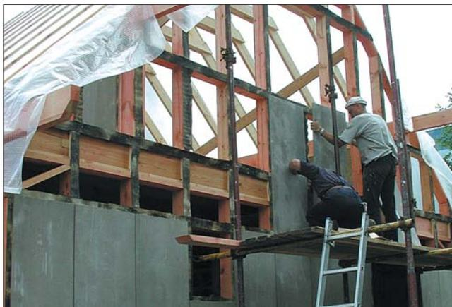
Рис. 5. Обшивка каркаса цементно-стружечными листами
