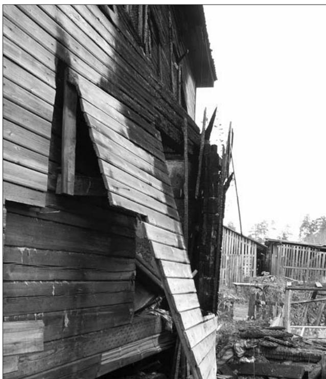
*Рис. 3. Разрушение торцевой стены при взрыве бытового газа*
