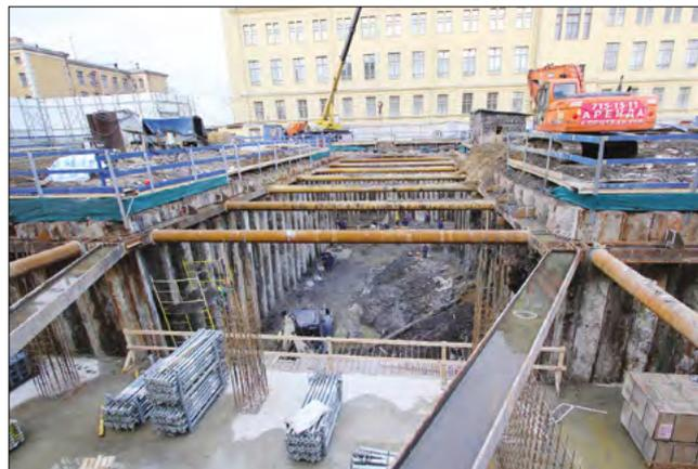
Рис. 4. Устройство подземного объема на Загородном пр. по методу «жесткого контура»
