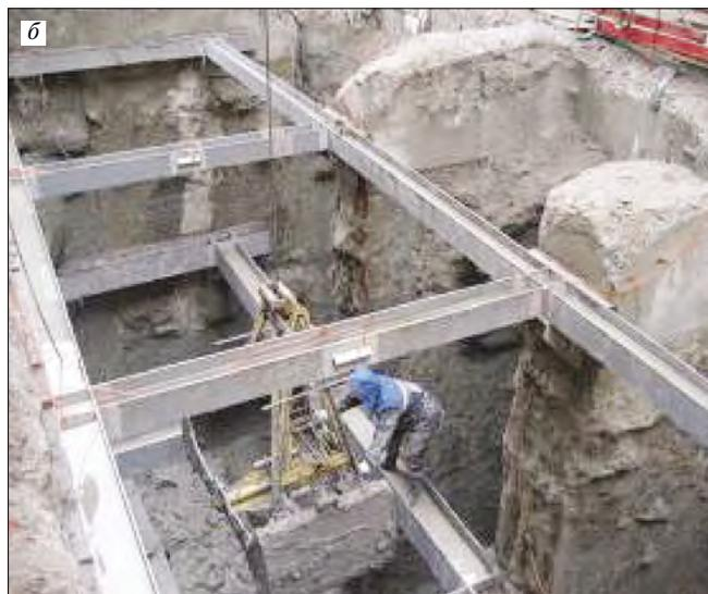
Рис. 1. Опытная площадка для апробации и адаптации технологии «стена в грунте» в условиях плотной застройки на слабых грунтах (Санкт-Петербург, Зоологический пер., д. 2-4): а – работа в непосредственном примыкании к расселенному зданию; б – вид «стены в грунте» с контрфорсами
