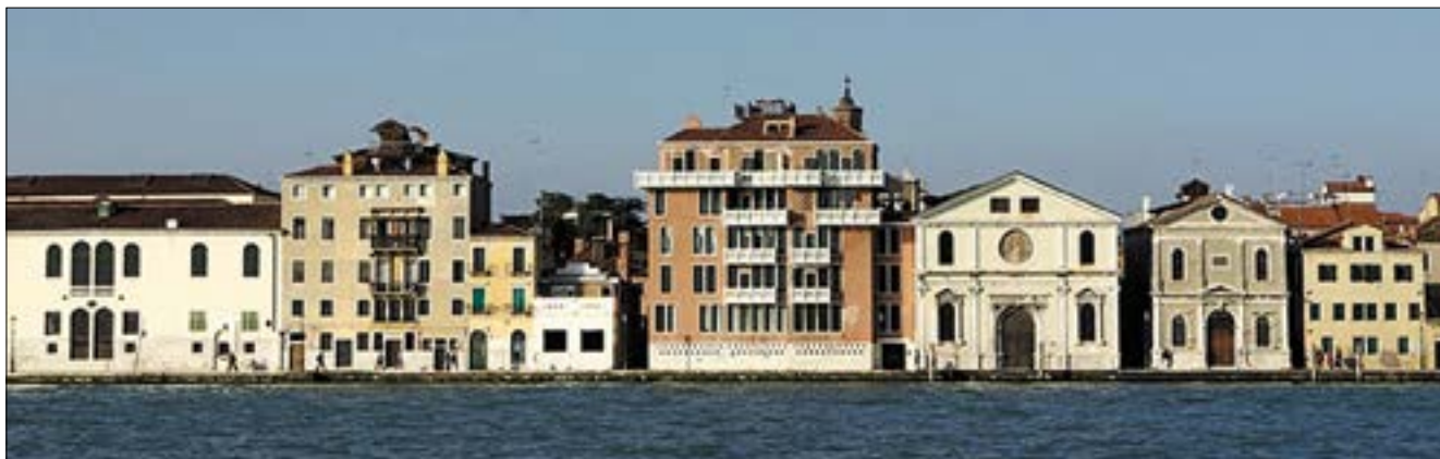
Рис. 4. Жилой дом на набережной Заттере в Венеции (Италия, 1959 г.), арх. И. Гарделла
