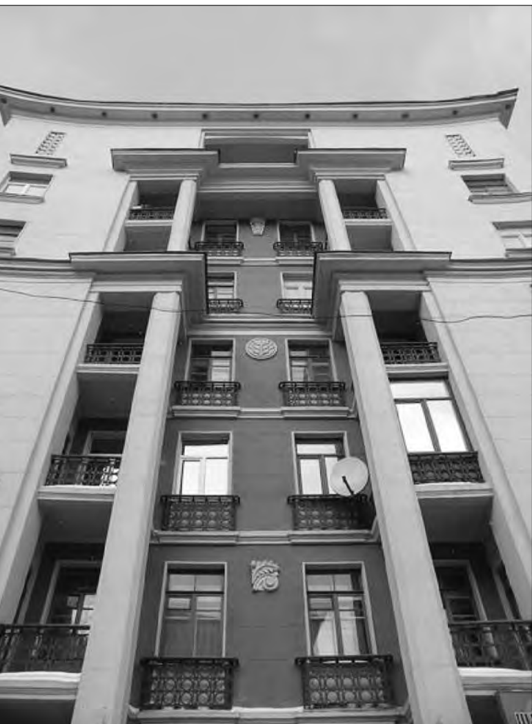
Рис. 4. Лоджии в доме на Ивановской ул.
