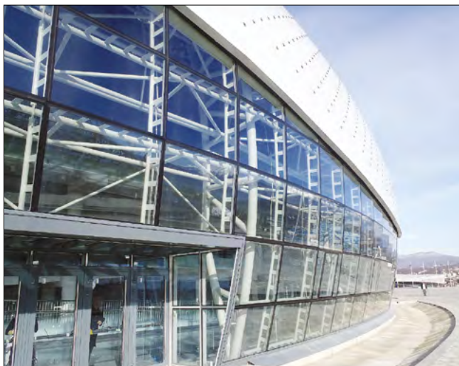
Рис. 5. Фрагмент фасада ледового дворца «Большой»
