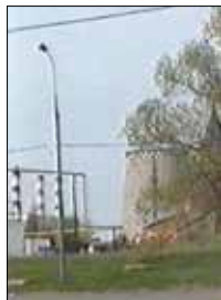
Рис. 2. Вид из Бусиново на ТЭЦ-21
