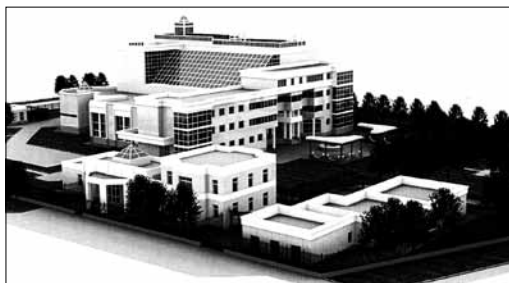
Рис. 7. Общий вид дипломатического комплекса России в Беларуси. На переднем плане — одноэтажный корпус инженерно-технических служб и консульский отдел. Далее расположены служебно-представительский и жилой корпуса. Они объединены остекленным атриумом (ООО «Инспецпроект»)
