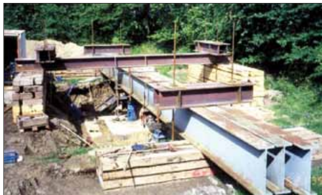
Рис. 3. Вид опытной площадки Tornhill [3] в Швеции (исследования Шведского геотехнического института, 2001)
