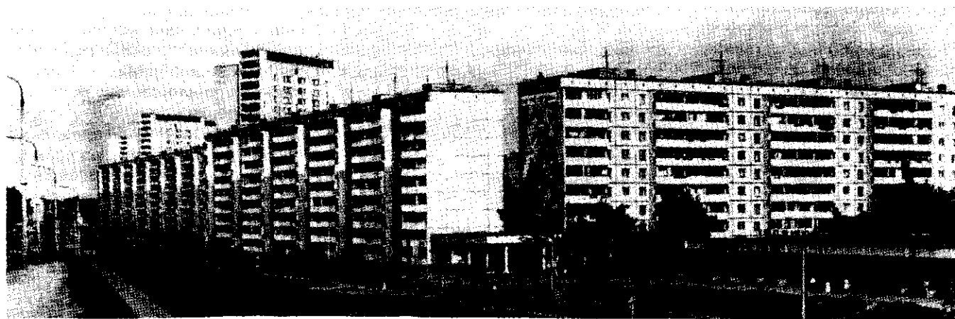
Панорама застройки 9-этажными домами серии 1-515
