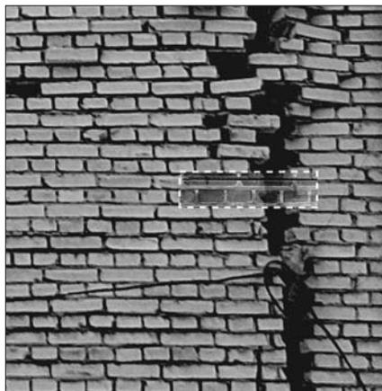
Рис. 3. Определение ширины трещины методом аналитической фотограмметрии с помощью накладываемого полупрозрачного модуля (выделен пунктиром)
