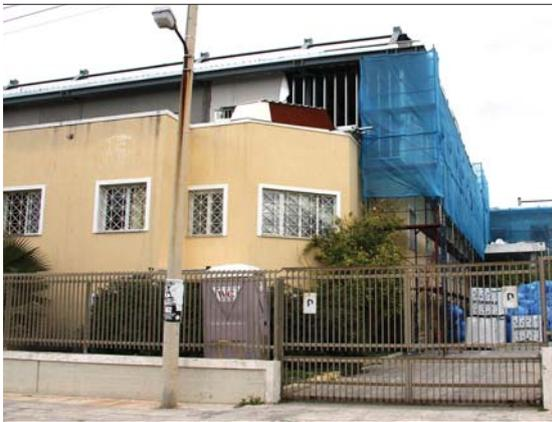
Надстройка дополнительного этажа над эксплуатируемым зданием медицинского центра «Касталия» (Афины)
