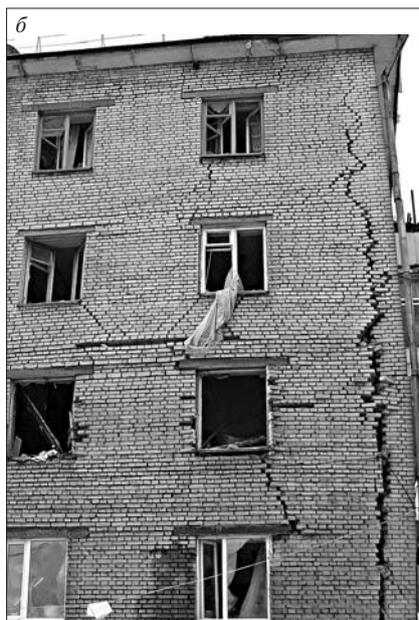
**Рис. 1.** Здание после взрыва бытового газа: а — общий вид; б — участок наибольшего разрушения стен
