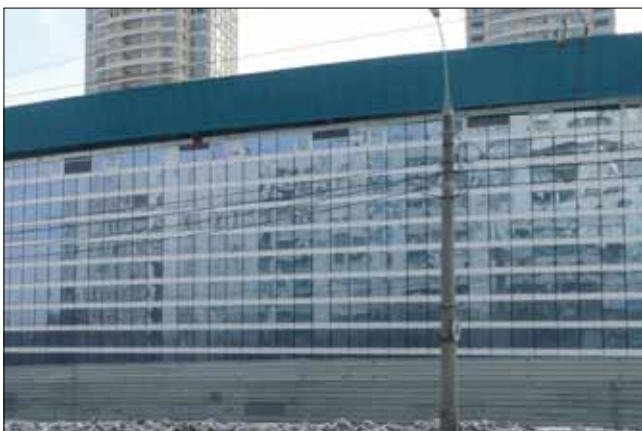
Рис. 2. Сильные видимые оптические искажения в остеклении бассейна стеклопакетами малых размеров
