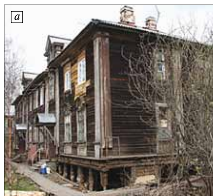
Рис. 1. Деревянное двухэтажное многоквартирное здание, подготовленное для замены свай: а — общий вид; б — конструкции деревянных свай, имеющих характерные биоповреждения
