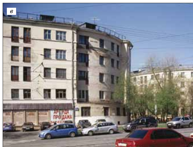
Рис. 6. Квартал Преображенское: а – сохранившиеся элементы застройки; б – угловая секция жилого дома; в – общий вид угловой секции на ул. Преображенский Вал. Фото Н.Ю. Васильева
