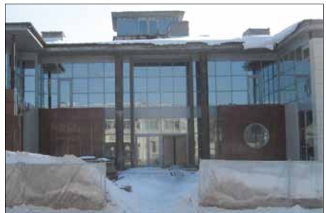
Рис. 3. Сильные видимые оптические искажения деформированных стеклопакетов
