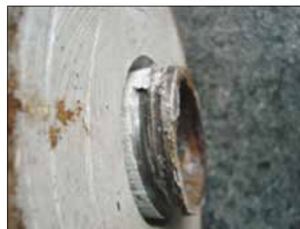
Рис. 8. Характер разрушения контакта винтовой тяги
