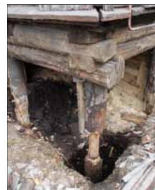
Рис. 2. Интенсивное биоразрушение деревянных свай вблизи поверхности грунта, где имеется свободный доступ воздуха, необходимого для развития грибов
