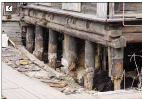
Рис. 1. Деревянное двухэтажное многоквартирное здание, подготовленное для замены свай: а — общий вид; б — конструкции деревянных свай, имеющих характерные биоповреждения
