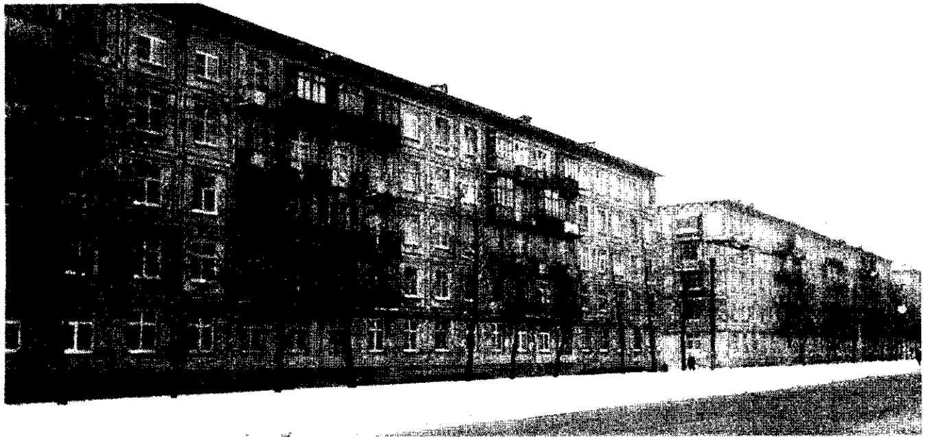
Застройка улицы Седова первыми крупнопанельными домами. Архитекторы: Е.А.Левинсон, Д.С.Гольдгор, Н.И.Яккер и др.
