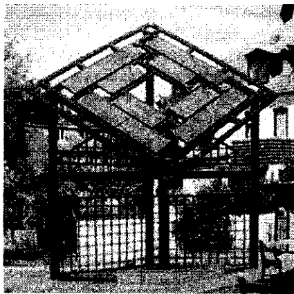
Рис. 4. Павильон с солнечными фотоэлектрическими панелями
