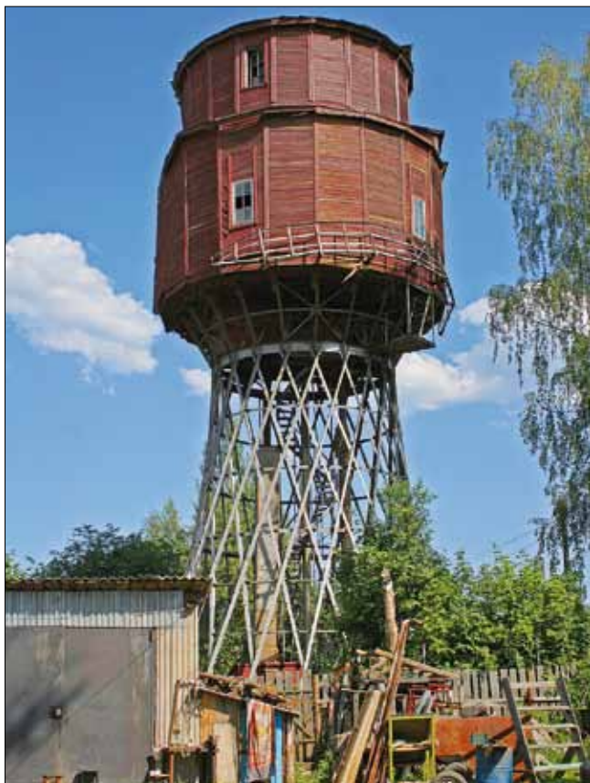
Рис. 2. Гиперболоидная водонапорная башня конструкции академика В.Г. Шухова на станции Петушки (Владимирская обл.). Памятник архитектуры
