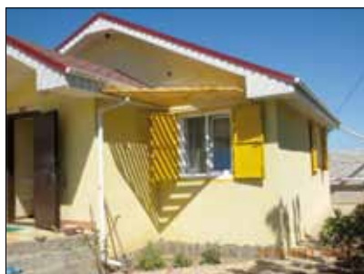
Рис. 11. Солнцезащитное устройство. Дом возле Качи, Республика Крым. Проект Н. Шарова, М. Моргуновой
