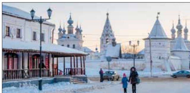
Рис. 4. Ресторан в историческом здании в г. Юрьев-Польском (Владимирская обл.)
