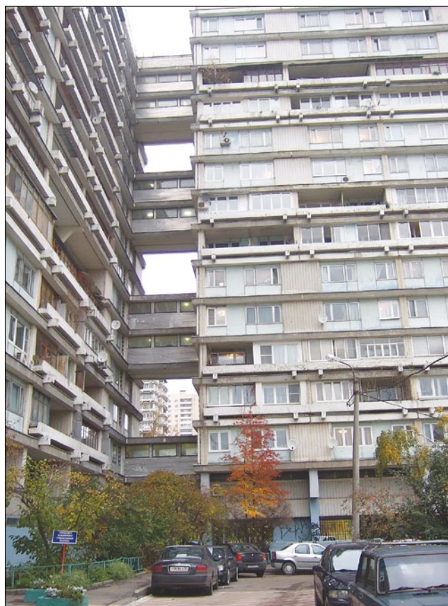
Рис. 12. Крытые переходы между жилыми корпусами
