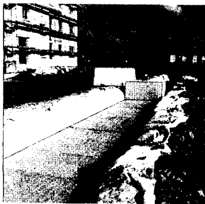
Укладка блоков в траншею
