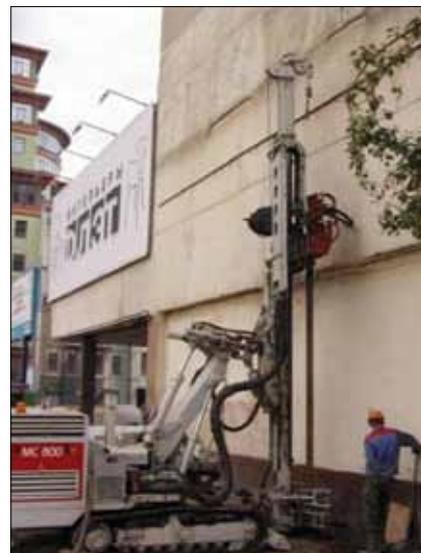
Рис. 7. Устройство скважин для смолизации грунта в острие существующих свайных фундаментов д. 2 по ул. Долгоруковской (июнь 2007 г.)
