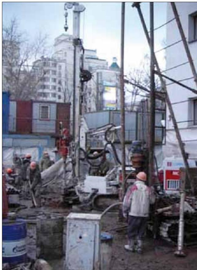
Рис. 13. Цементация фундаментов по оси 3 д. 43 по Оружейному пер. и устройство армированных jet-свай  $\varnothing 500$  мм (2007 г.)
