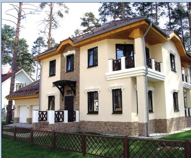
Дом фирмы «Метеорит и К<sup>о</sup>». Конструктивное решение ограждающих конструкций – монолитный железобетон в несъемной пенополистирольной опалубке ARXX. Общая площадь 295 м<sup>2</sup>
