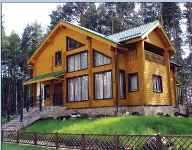
Дом ООО «Водоканалстрой» выполнен из клееного профилированного бруса без дополнительного утепления и отделки. Для внутренней отделки также использован клееный брус и шпунтованная доска без дополнительной отделки. Цокольный этаж засыпан землей (имитация альпийской горки)
