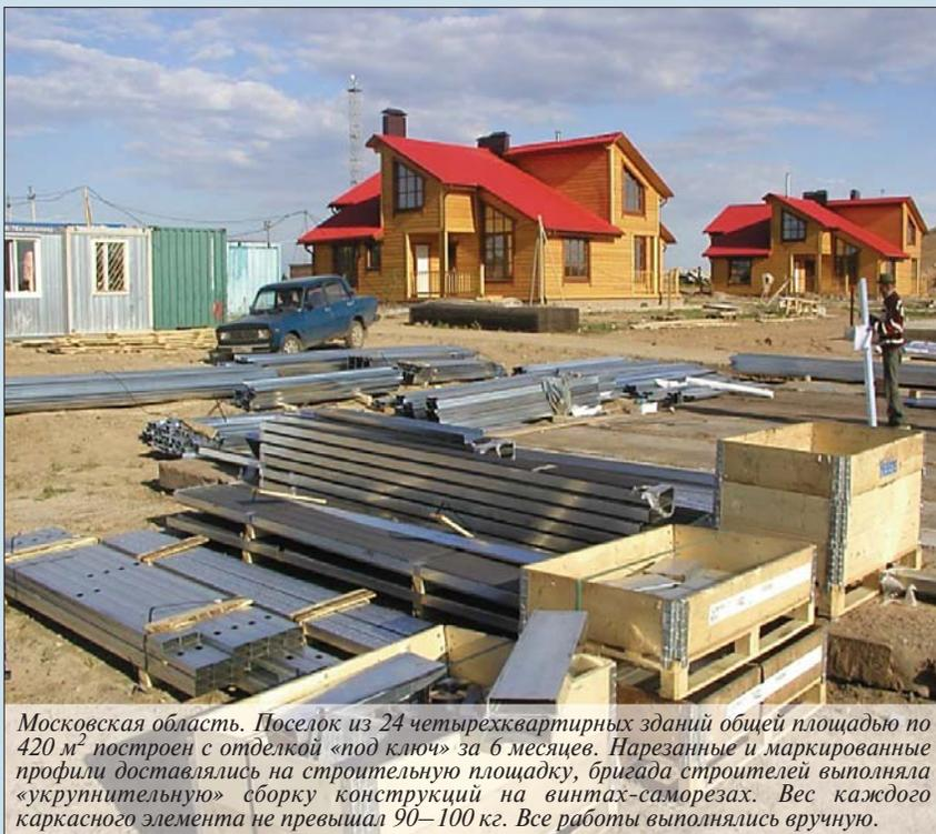
Московская область. Поселок из 24 четырехквартирных зданий общей площадью по  $420 \text{ м}^2$  построен с отделкой «под ключ» за 6 месяцев. Нарезанные и маркированные профили доставлялись на строительную площадку, бригада строителей выполняла «укрупнительную» сборку конструкций на винтах-саморезах. Вес каждого каркасного элемента не превышал 90–100 кг. Все работы выполнялись вручную.
