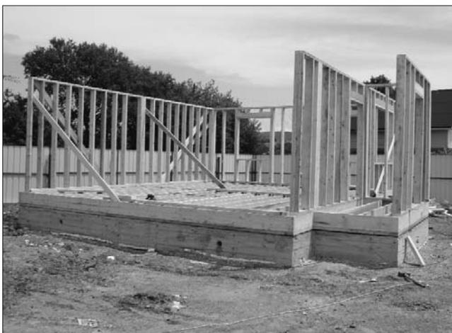
Рис. 1. Сооружение каркаса дома
