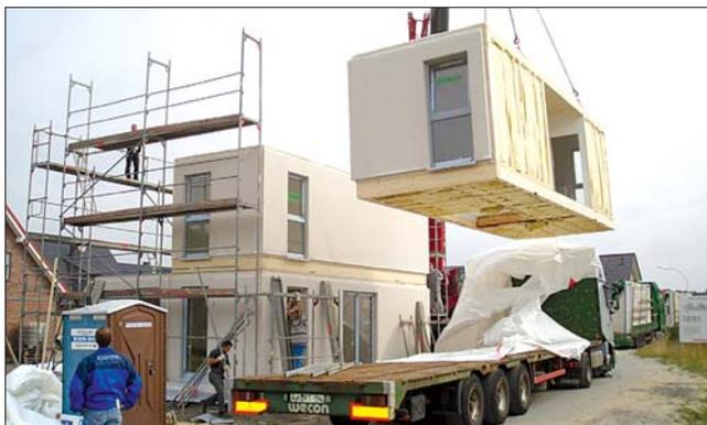
Монтаж объемных модулей, изготовленных на заводе
