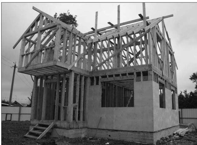
Рис. 2. Обшивка каркаса дома
