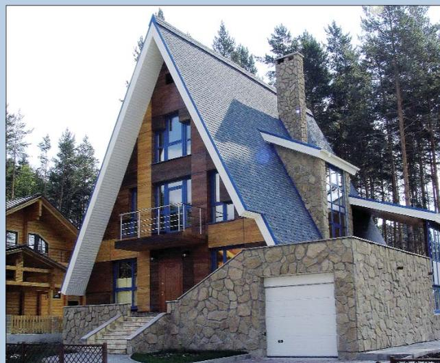
Фирма «Стин Вест» применила для строительства коттеджа технологию монолитного бетонирования с утеплением фасада и его отделкой с вентилируемым зазором. Общая площадь 165 м<sup>2</sup>
