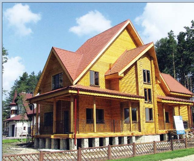
Дом фирмы «Новый дом» (Тюмень) полностью выполнен из клееного бруса. Площадь застройки 215 м<sup>2</sup>, общая площадь дома 256 м<sup>2</sup>. Гараж-пристройка на одну машину
